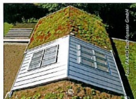
Zwölf Maßfenster von Fakro ersetzen ein Glasdach in der Eingangshalle eines Dorstener Verwaltungsgebäudes.
