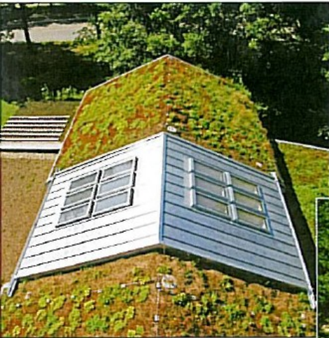
Zwölf Maßfenster von Fakro ersetzen ein Glasdach über der Eingangshalle eines Dorstener Verwaltungsgebäudes.
