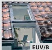
Der Eindeckrahmen EUV/B ermöglicht die Verbindung des Kniestock-Fensters mit Dachfenstern beliebiger Konstruktion.
